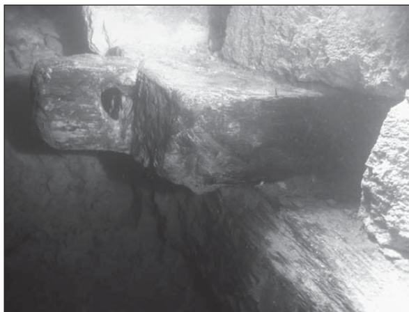
Рис. 1. Дерев'яні балки в основі фундаменту башти 1
