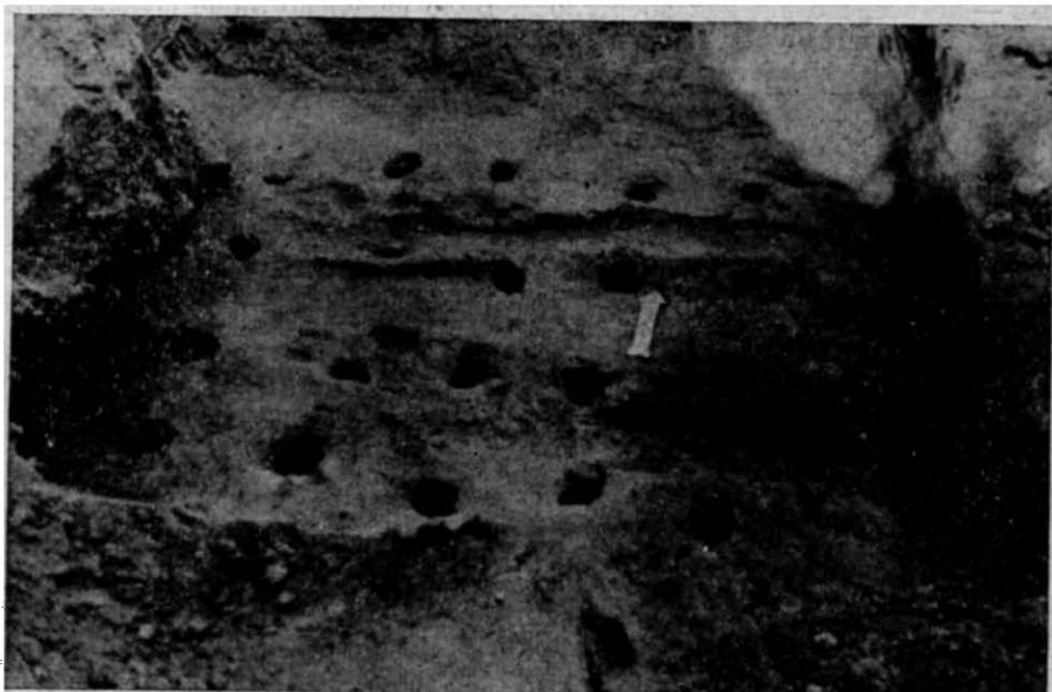
Рис. 2. Система кілків під фундаментами південної стіни.
