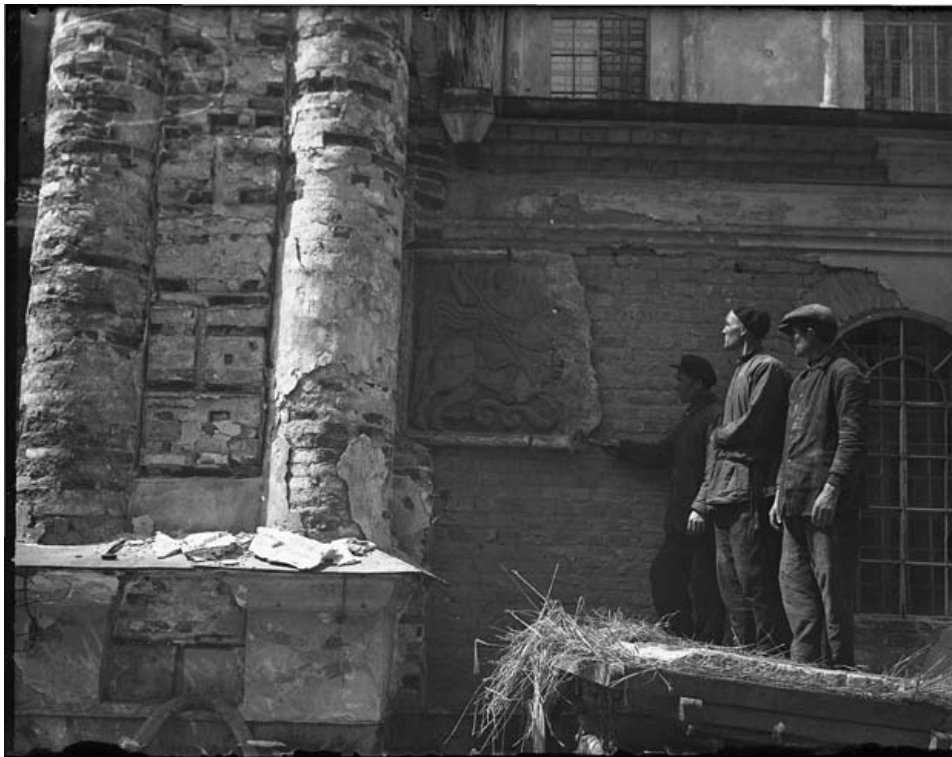
Рис. 3. Зняття шиферної (пірофілітової) плити
