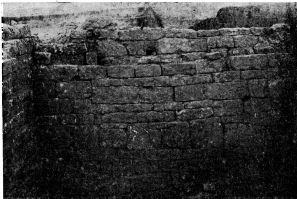
Вигляд підвального приміщення, відкритого р. 1927, для якого частково використана була стінка ранішої доби.
